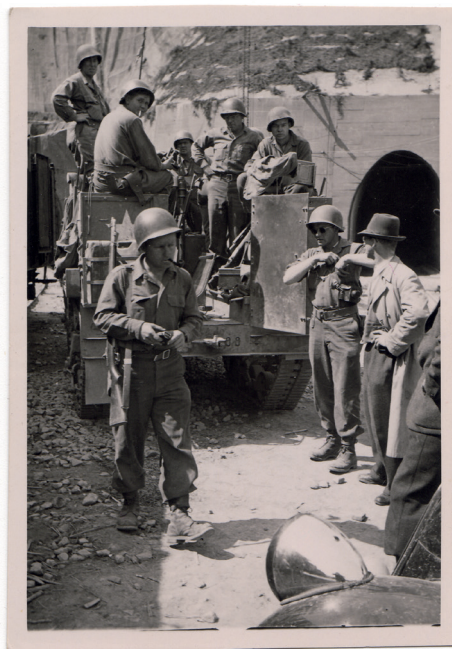
Spähtrupp der US-Armee vor einem Eingang zur Stollenanlage „Bergkristall“, St. Georgen, 5. Mai 1945. Quelle: MM, Sammlung Pierre-Serge Choumoff.
